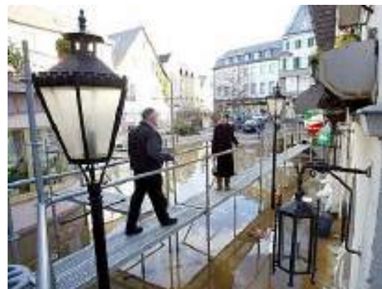
Abb. 94: Hochwassersteg mit EGS (THW)
