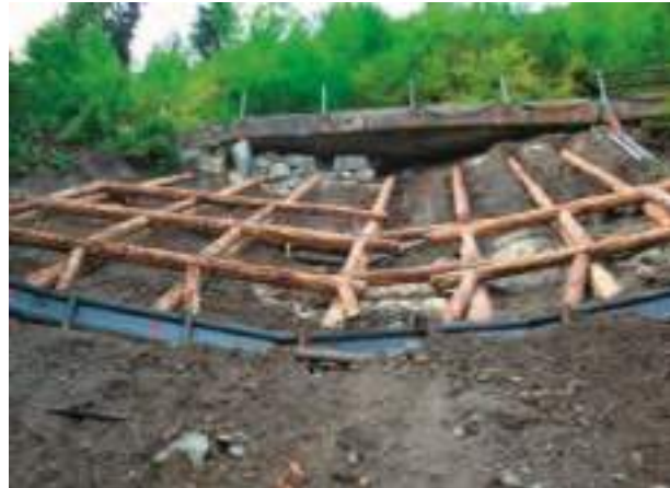
Abb. 70: Ausfachtung mit Distanzhölzern (Ammann Ingenieurbüro AG)
