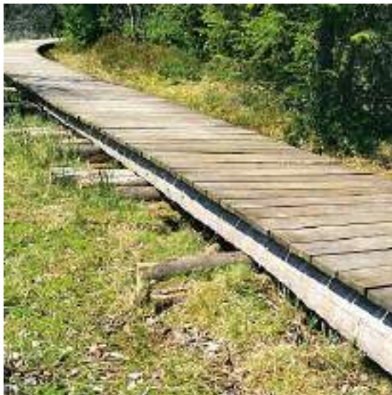
Abb. 82: Konstruktion mit Querbalken (ASTRA)
