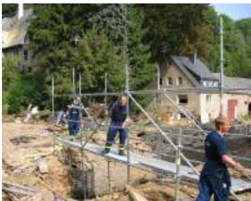
Abb. 93: Trümmersteg mit EGS (THW)
