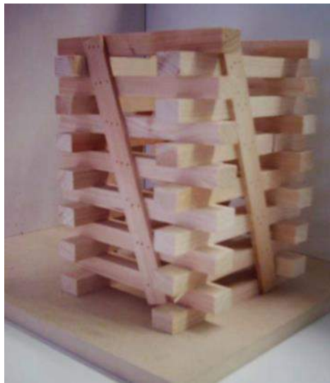
Abb. 66: Sichern von Kreuzholzstapel
