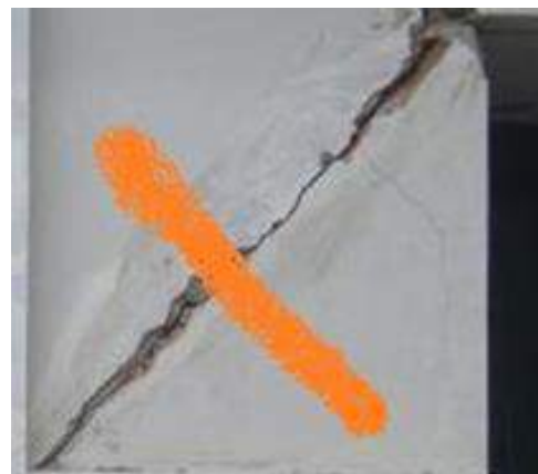
Abb. 17: Überwachung mit Farbstrich (Regina Wenk)
