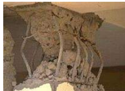
Abb. 5: Freiliegende Armierungseisen
