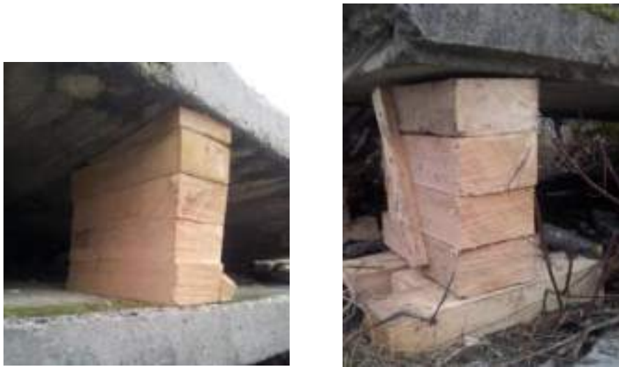
Abb. 74: Beispiele von einfachen Kantholzstapeln (Regina Wenk)
