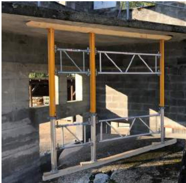
Abb. 55: Senkrechtcs Flächenfachwerk mit Systemstützen aus dem Bausektor
