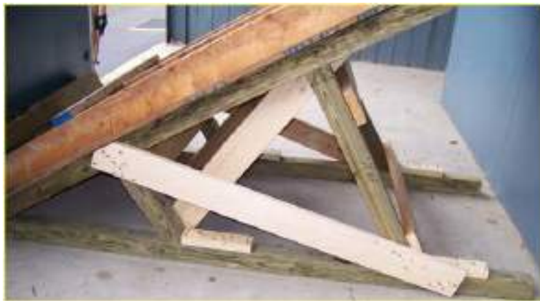
Abb. 92: Schräges Raumfachwerk aus Holz (rechtwinklige Methode) (FEMA)
