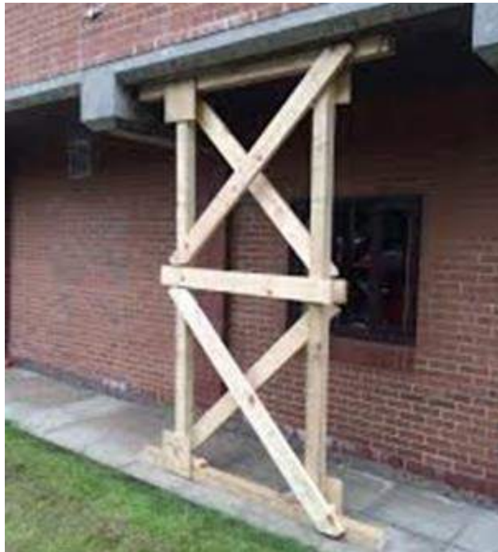
Abb. 54: Beispiel eines senkrechten Flächenfachwerks aus Holz (FEMA)
