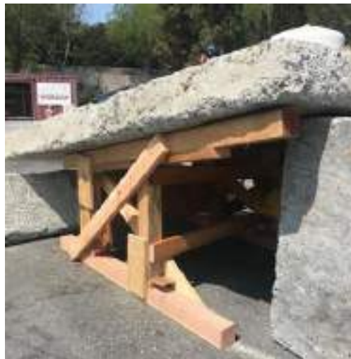
Abb. 95: Schräges Raumfachwerk aus Holz (senkrechte Methode) (FEMA)
