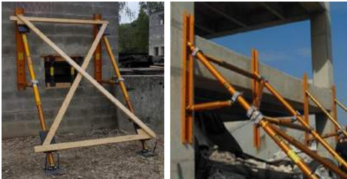
Abb. 106: Strebstützen mit Systemstützen aus dem Rettungssektor
