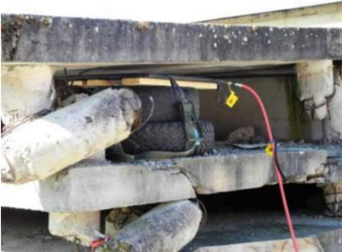
Abb. 115: Beispiel alternative Abstützung: Mit Steinen gefüllte Pneus, gegen seitliche Verschiebung mit Zurrigurt gesichert und mit Hebekissen kraftschlüssig eingespannt (Rettungskette Schweiz)
