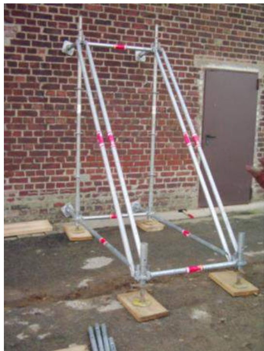
Abb. 111: Strebstützböcke aus Systemstützen und aus Gerüstbaumaterial (EGS) (THW)
