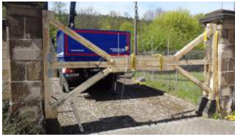
Abb. 79: Beispiel eines Sprengwerks (THW)
