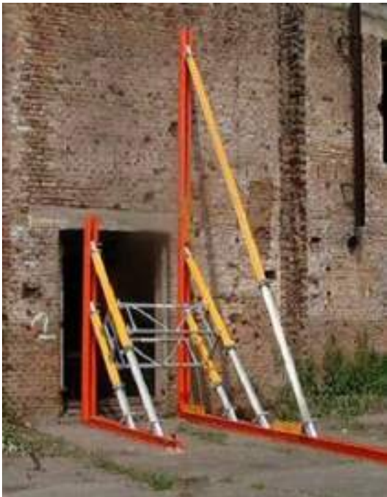
Abb. 111: Strebstützböcke aus Systemstützen und aus Gerüstbaumaterial (EGS) (THW)
