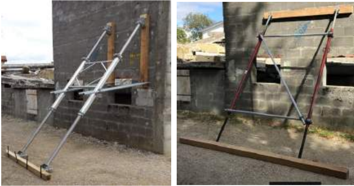
Abb. 105: Einfache Strebstützen mit Systemstützen und mit Richtstützen (ohne Streichbalken) aus dem Bausektor
