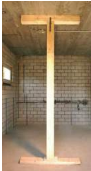
Abb. 45: Senkrechte Holzstütze (Blockhaus, THW)
