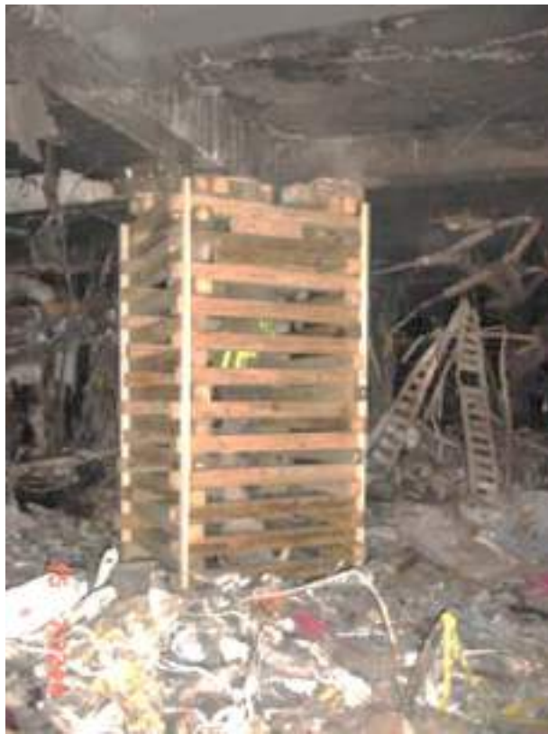
Abb. 69: Abstützung mit Kreuzholzstapel im Pentagon nach dem Terroranschlag (FEMA)
