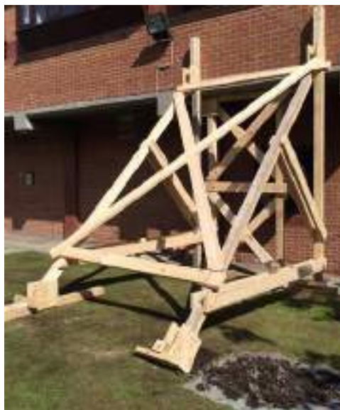
Abb. 22: Wandabstützung aus Holz (FEMA)
