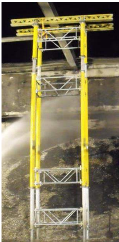
Abb. 60: Senkrechte Raumfachwerke aus Systemstützen und aus Gerüstbaumaterial
