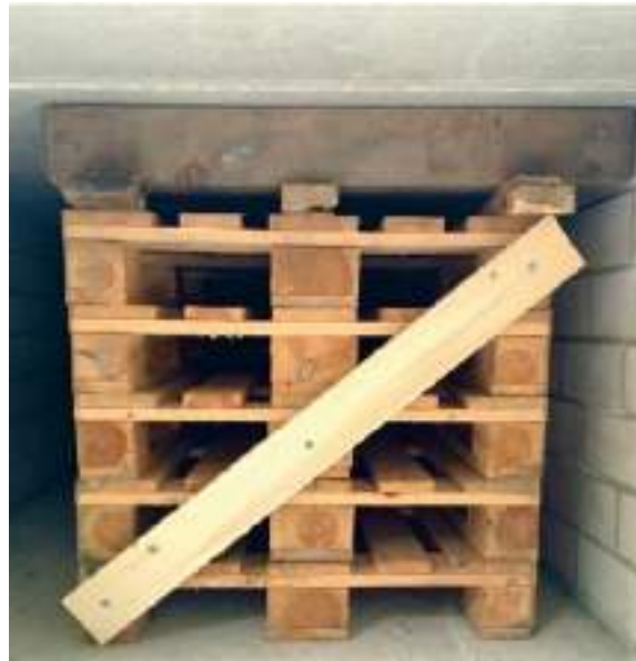
Abb. 71: Beispiel eines korrekt aufgebauten Palettenstapels (Blockhaus, THW)
