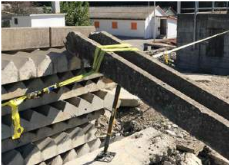
Abb. 87: Schnellsicherung eines schrägen Bauteils mit einer Rettungsstütze und seitlicher Abspannung mit Zurrgurten gegen Verschiebung
