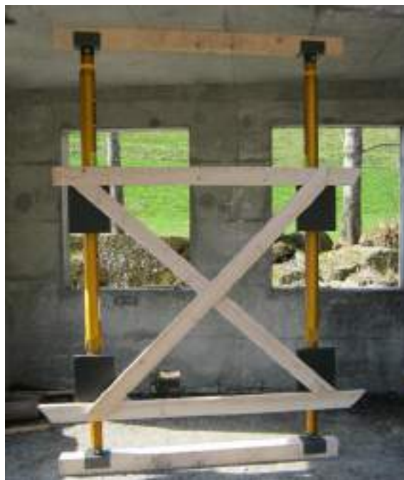
Abb. 56: Senkrechtcs Flächenfachwerk mit Systemstützen aus dem Rettungssektor
