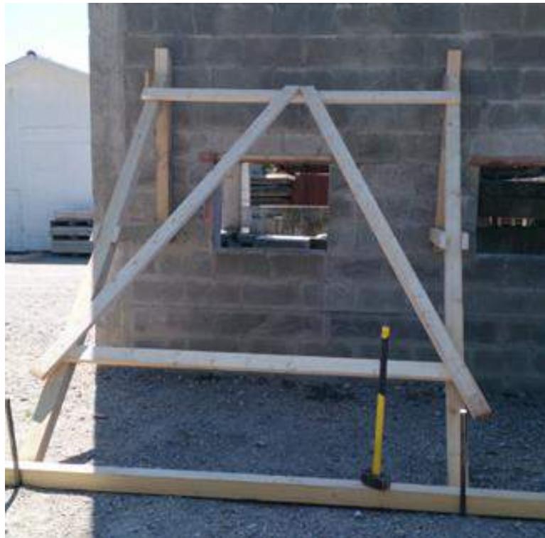
Abb. 104: Beispiel Strebstütze aus Holz
