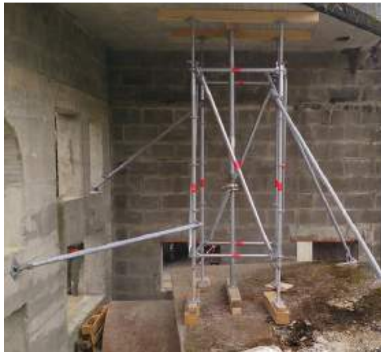
Abb. 60: Senkrechte Raumfachwerke aus Systemstützen und aus Gerüstbaumaterial
