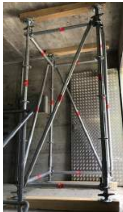
Abb. 26: Raumfachwerk mit dem EGS
