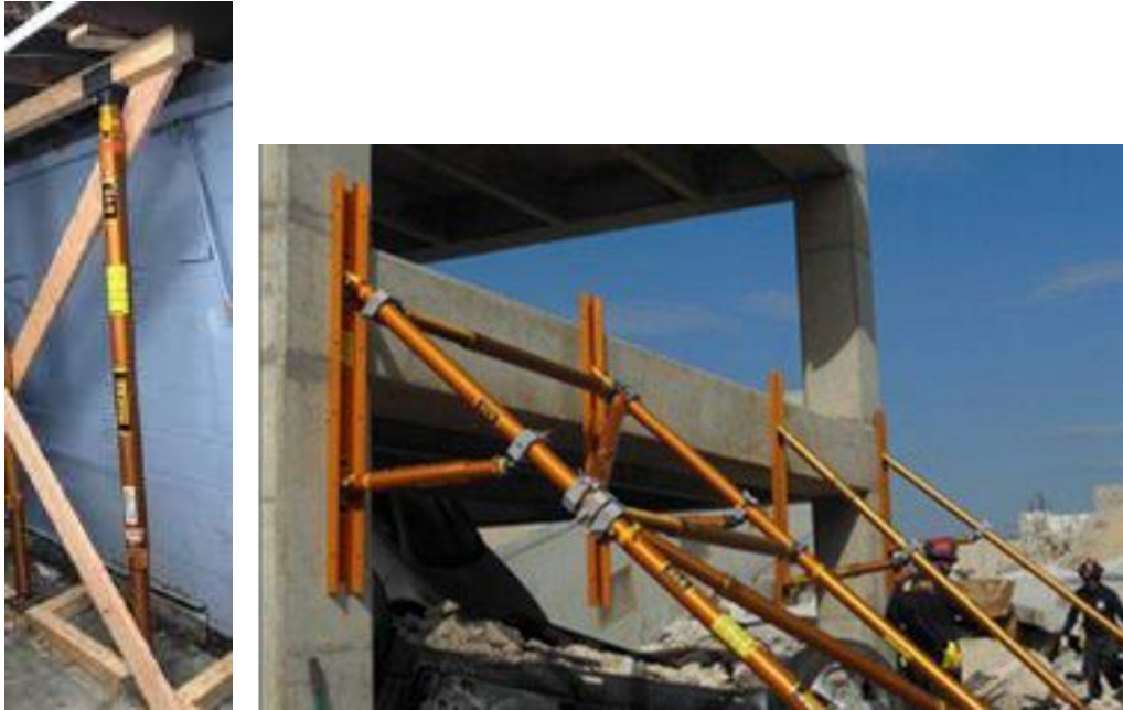
Abb. 27: Abstützungen mit multifunktionellen Rettungsstützen (Paratech))
