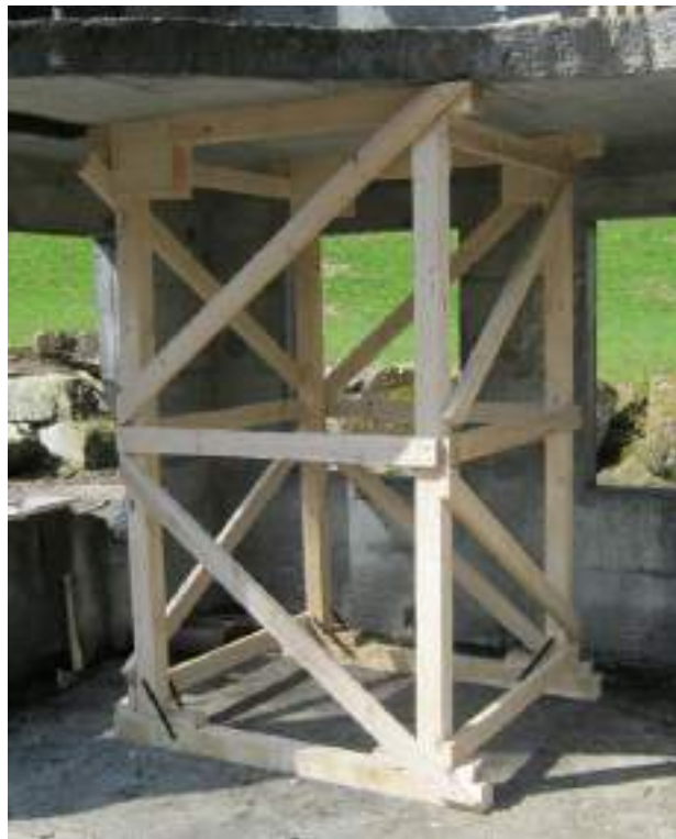
Abb. 59: Beispiel eines senkrechten Raumfachwerks aus Holz
