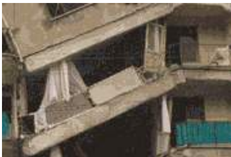
Abb. 4: Ausgefallene/überlastete Auflager
