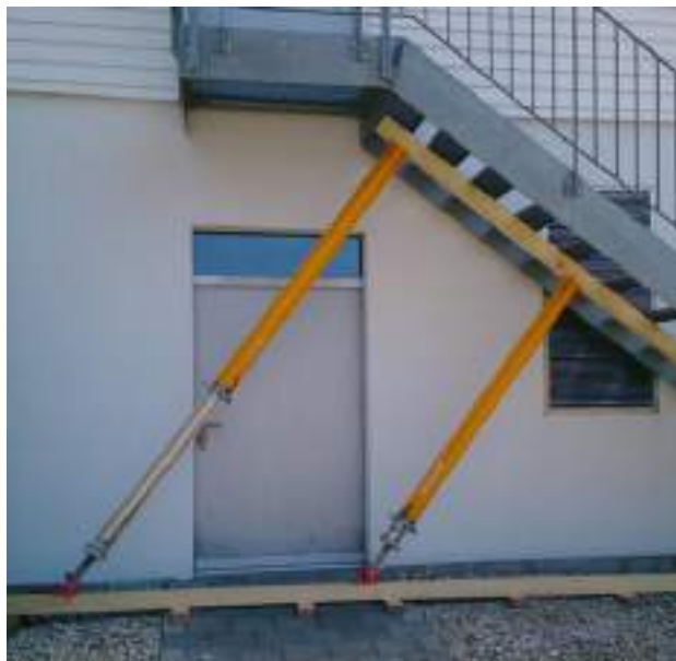
Abb. 90: Schräges Flächenfachwerk mit Systemstützen aus dem Bausektor (rechtwinklige Methode)
