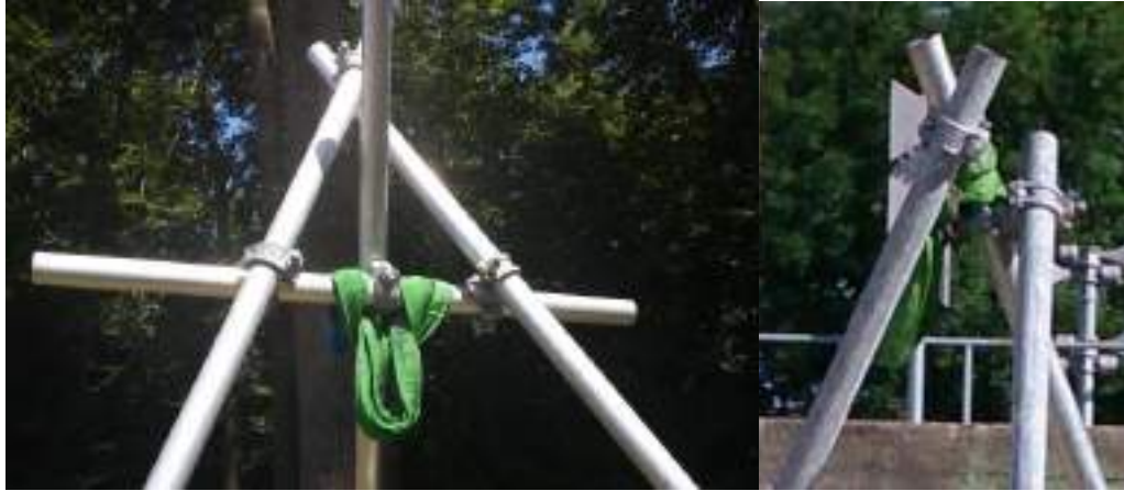
Abb. 49: Improvisierte Dreibeinkonstruktionen mit Gerüstrohren.
