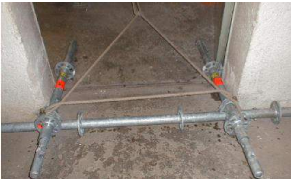
Abb. 19: Querriegel mit Gerüstrohren in einer Türöffnung (Technisches Hilfswerk THW).
