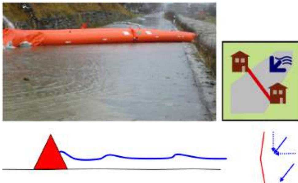
Abb. 27: Beispiel für das Absperren eines Abflusses auf einer Strasse, wodurch das Abfliessen des Wassers über die Strasse verhindert wird (Vereinigung Kantonalen Feuerversicherungen VKF).
