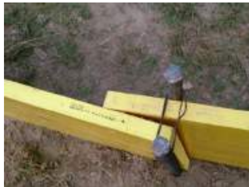
Sicherung der Armierungseisen mit Drilldraht
