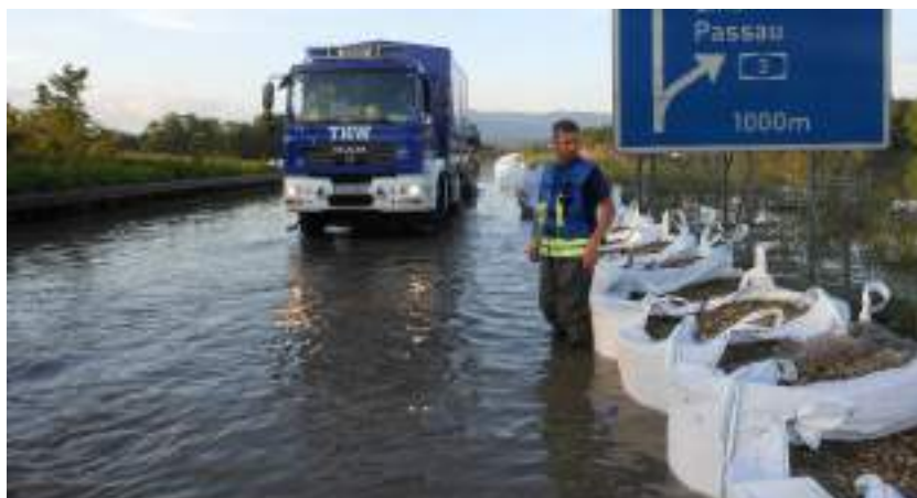
Abb. 62: Improvisiertes Behältersystem mit Industriesäcken (Technisches Hilfswerk THW).
