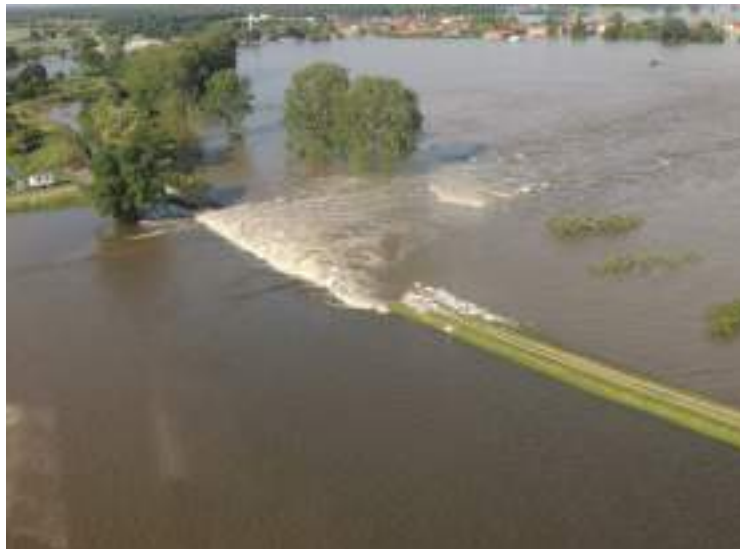
Abb. 68: Deichbruch (Robert Jüpner, Technische Universität Kaiserslautern).
