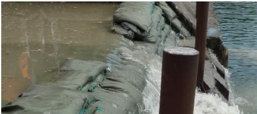
Abb. 41: Überströmter Sandsackdamm (Herbert Götschmann, BABS).
