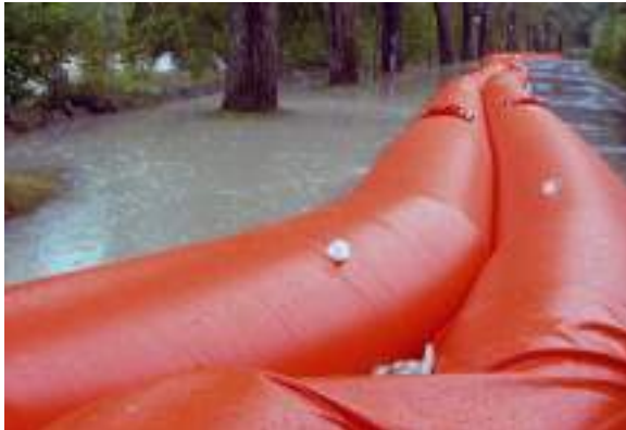
Abb. 60: Wassergefülltes Schlauchsystem (Beaver) und wassergefüllte Kunststoffelemente mit Stecksystem (Aeschlimann Hochwasserschutz AG).
