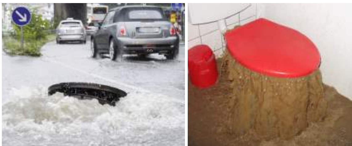
Abb. 14: Rückstau über die Kanalisation (Bruno Gerber, Tiefbauamt Kanton Bern).
