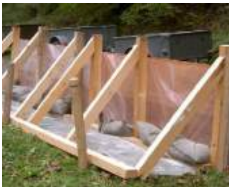
Zusätzliche Abstützung mit Kantholz
