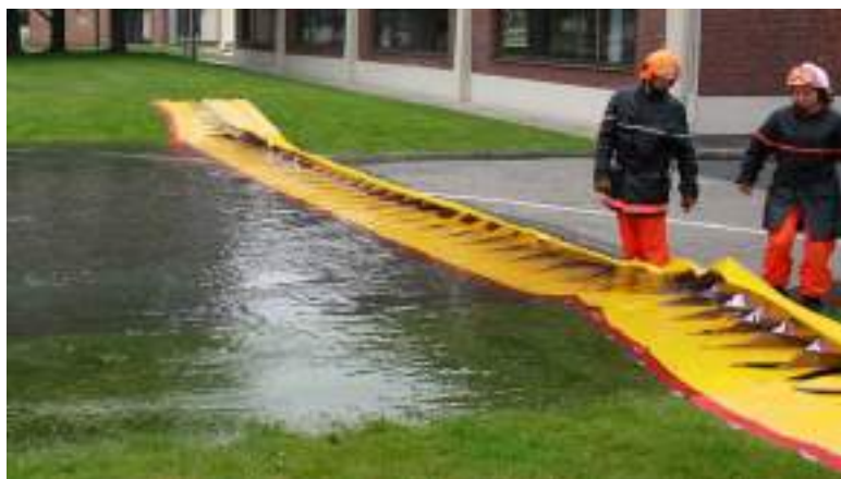
Abb. 61: Klappsystem im Einsatz (MegaSecur Europe).
