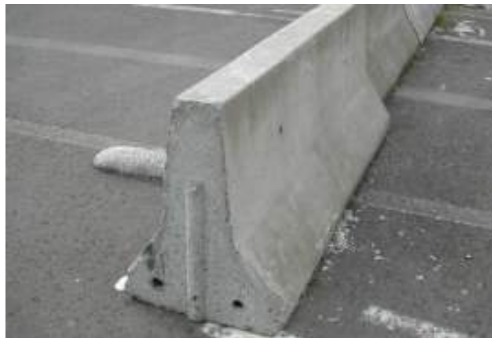
Abb. 64: Elemente mobiler Betonschutzwände (Wikipedia).
