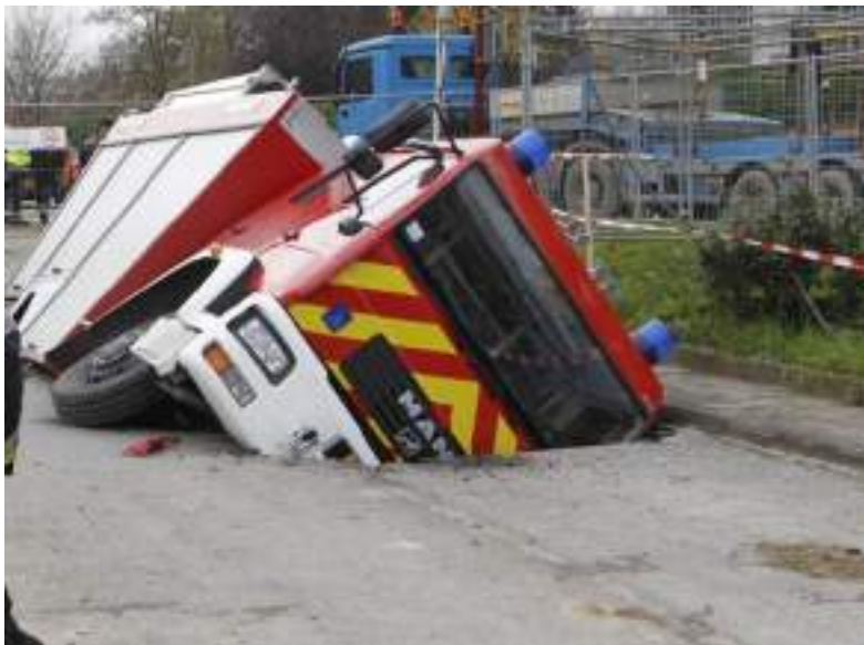
Abb. 19: Fahrzeugeinsturz wegen unterspülter Strasse (Luxemburger Wort).
