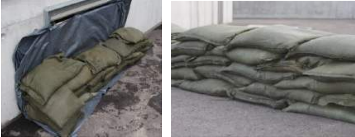
Abb. 49: Sicherung eines Kellerfensters bzw. eines Durchgangs (Gebäudeversicherung Bern GVB).
