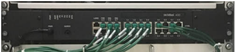
Abb 42: Frontansicht des Mitel 430 mit Ports für externe Verbindungen.
