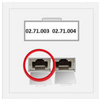
Abb 47: Anschlussdose mit seiner spezifischen Nummerierung (Beispiel: Anschlussdose 3 im Telematikzentrum).
